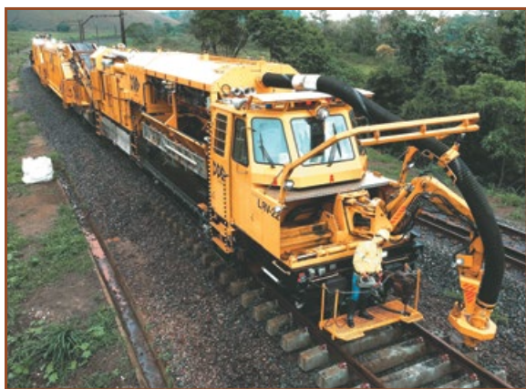
▲ Desguarnecedora de espaços confinados Rail Vac fabricada pela LORAN e de propriedade da MRS Logística (Foto: Renan Moreira)
